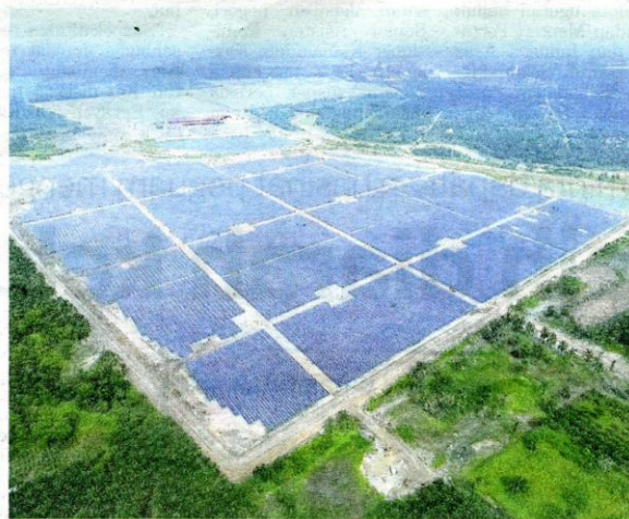
PROJEK LSS terbesar di Malaysia yang terletak di kawasan seluas 98 hektar ini menggunakan 230,000 panel solar untuk menjana tenaga elektrik.
